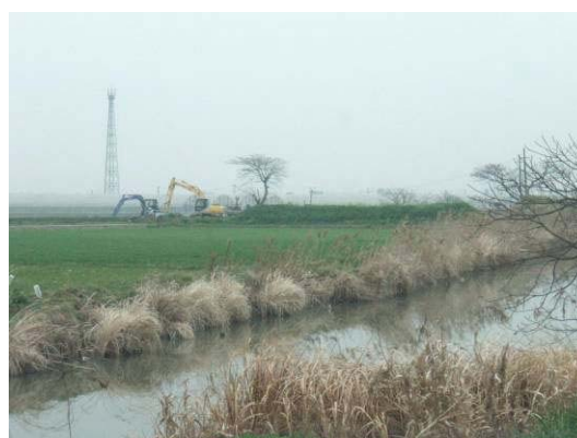
写真 5-2 有明海の堤内地の状況 水面が高く、地表面との比高がわずか である
