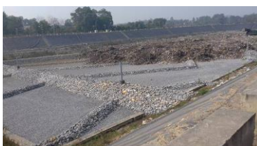
福岡方式廃棄物処分場の整備支援 (ハノイ市、タイ・シーキウ市)
