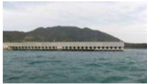
沖に整備した防波堤
