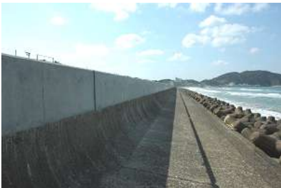
堤防の嵩上げ
