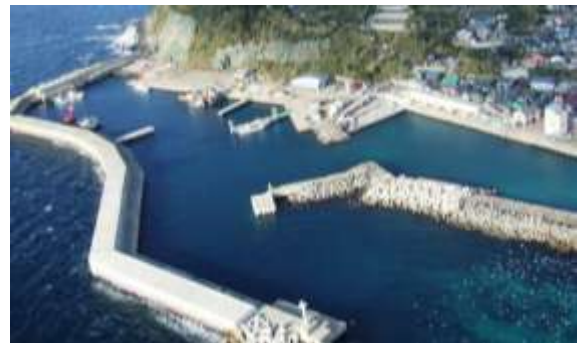
防波堤 (福岡市・小呂島漁港)
