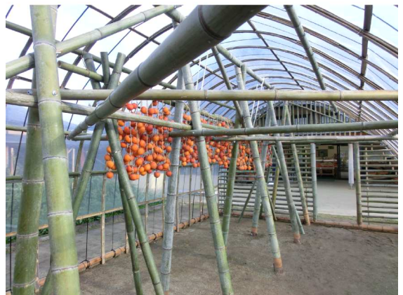
竹製ビニールハウスの内部
