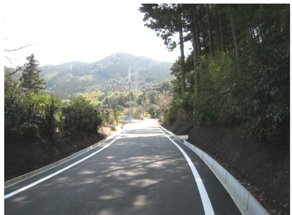
全線開通した「貫山線」林道
