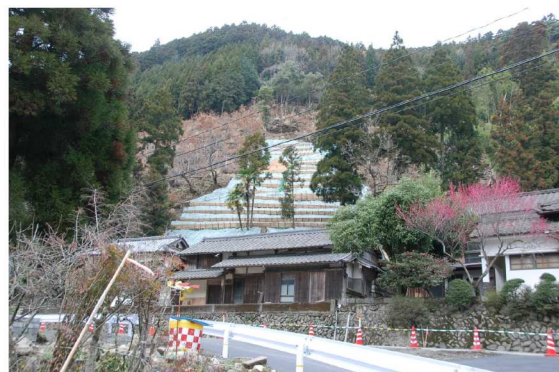
山崩れの再発防止のための山腹工
