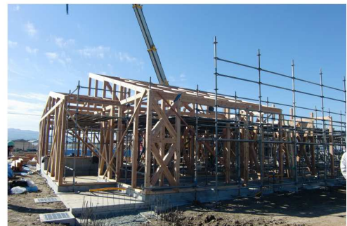
建て込みの状況
