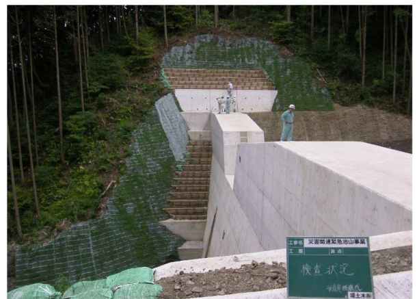
土石流の衝撃を考慮した治山ダム
