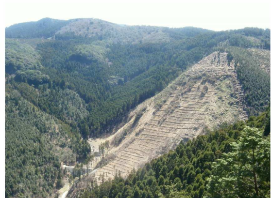
施工4年経過後の山腹工事箇所
