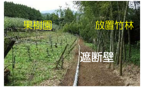
遮断壁の埋設による侵入防止
