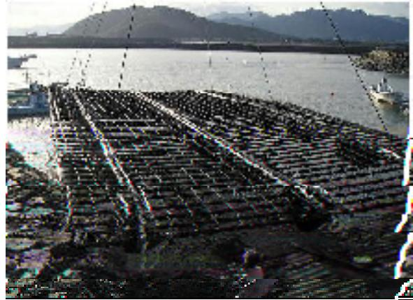
カキイカダの開発にあたっては、耐波性資材として、従来の孟宗竹に代えて腐食せず強度に優れたFRP製パイプを使用しました。また、イカダの浮体として、海水を入れることにより浮力が調整できるフロートを使用し、常に必要最小限の浮力でイカダを浮かべることで、振動が軽減できる構造としました。
