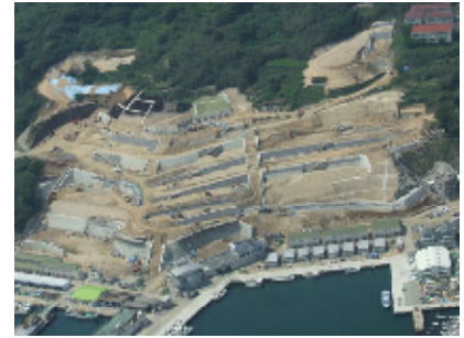
復旧が進む玄界島
