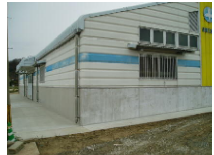
復旧した志賀島支所漁具倉庫
