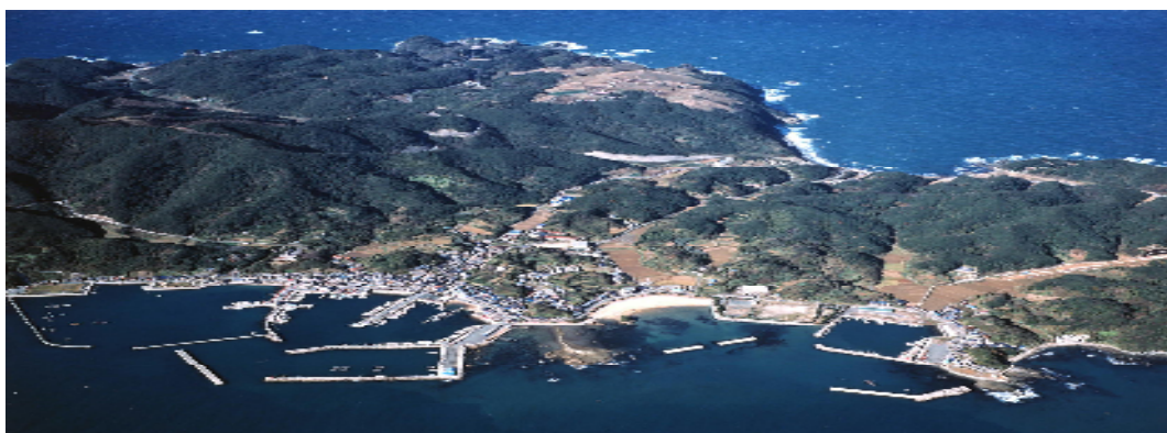
漁港の全体写真（宗像市・大島漁港）
