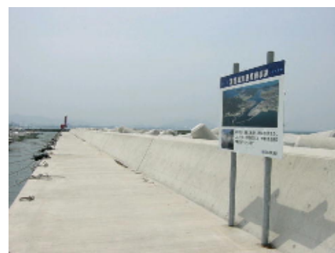
防波堤（福津市・津屋崎漁港）
