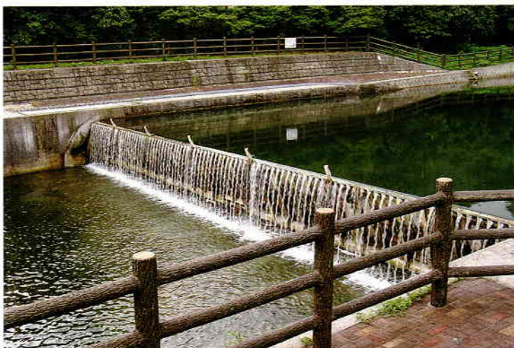
芳賀堰 (鞍手・宮田工業用水道)
