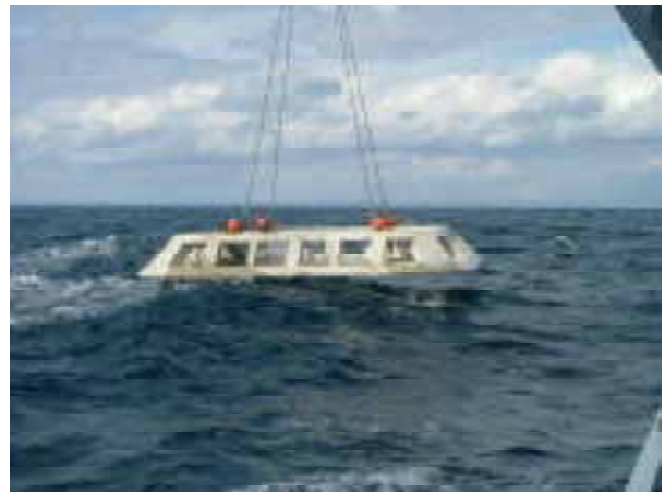
魚礁の設置工事
