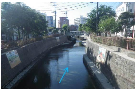
写真 1.3 栄橋下流 (0k440) 付近
