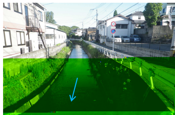
写真 1.6 市道七浦橋 (2k212) 上流付近
