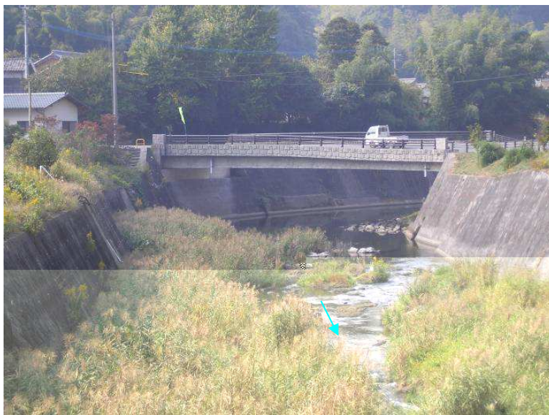
写真 1.10 白木川〔0k780、和田1号橋〕
