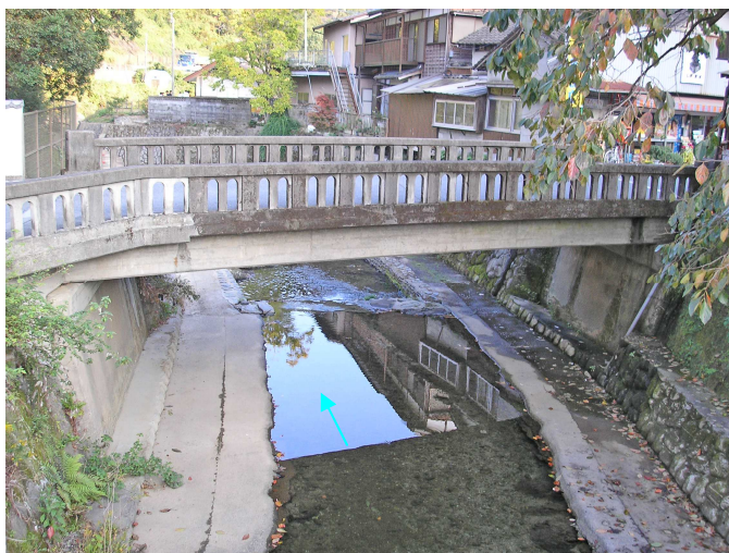
写真 1.12 松尾川 [0k049、長瀬橋]
