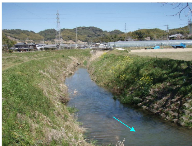
写真 1.2 楠田川 [6k200、山崎 2 号橋より上流]
