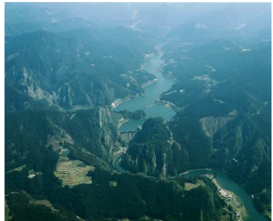
写真 1.25 矢部川上流部（日向神ダム付近）
