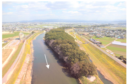
写真 1.26 矢部川中流部（船小屋温泉大橋付近）
