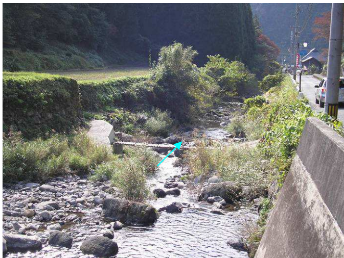
写真 1.21 縦鶴川 [0k250、無名橋]
