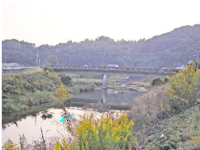
写真 1.11 辺春川 [1k300、中通り橋]
