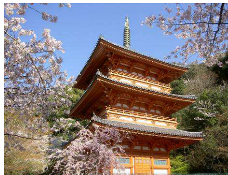
写真 1.29 県有形文化財 清水寺三重塔 (みやま市瀬高町)
