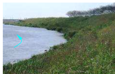
写真 2.5 船小屋地区の河川状況
