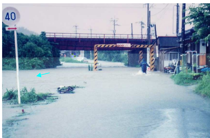
写真 1.33 平成24年7月洪水 楠田川 みやま市高田町下楠田 JR 橋付近の被災状況
