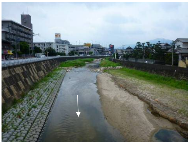
写真- 1.1 樋井川 [3k870、田島橋より上流]
