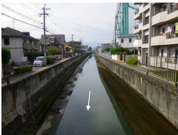
写真- 1.2 七隈川 [0k070、一の橋より上流]
