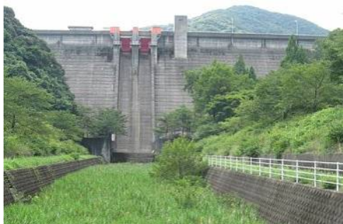
写真 2.4 ます淵ダム (昭和 48 年完成)
