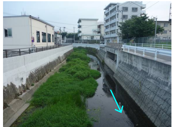
写真 1.8 神嶽川 地下調節池付近
