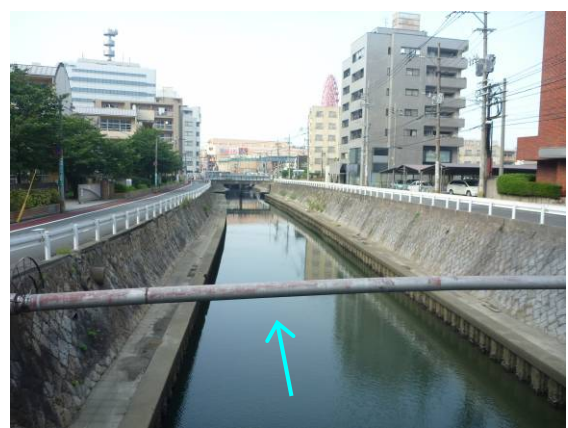
写真 1.10 砂津川 寿橋付近
