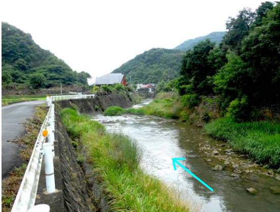
写真 1.13 東谷川 高津尾橋下流
