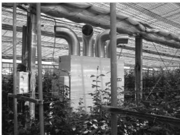
写真6、7 ヒートポンプの設置事例
