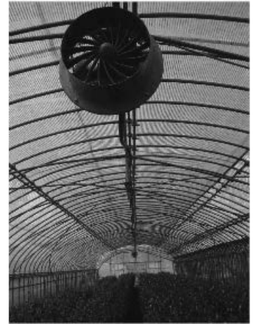
写真5 循環扇の設置
