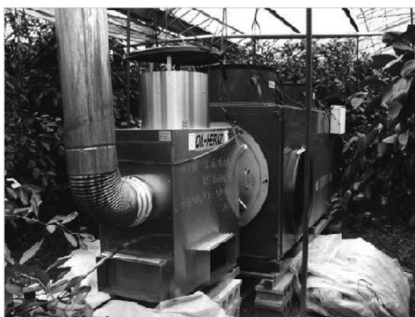
写真8、9 排熱回収装置
