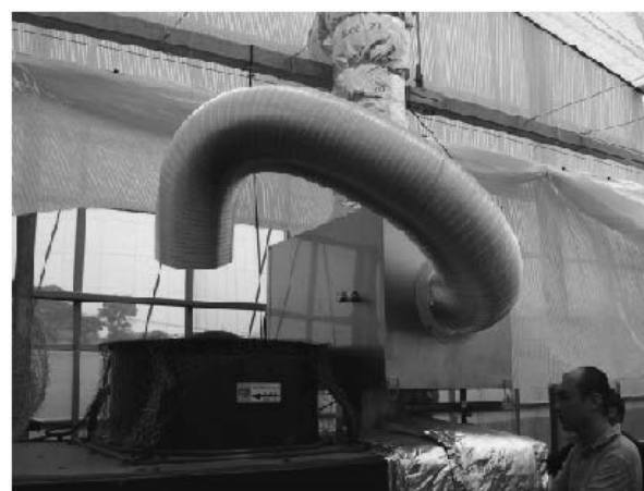
写真8、9 排熱回収装置
