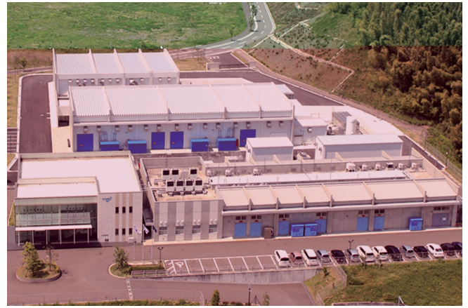
水素エネルギー製品研究試験センター
