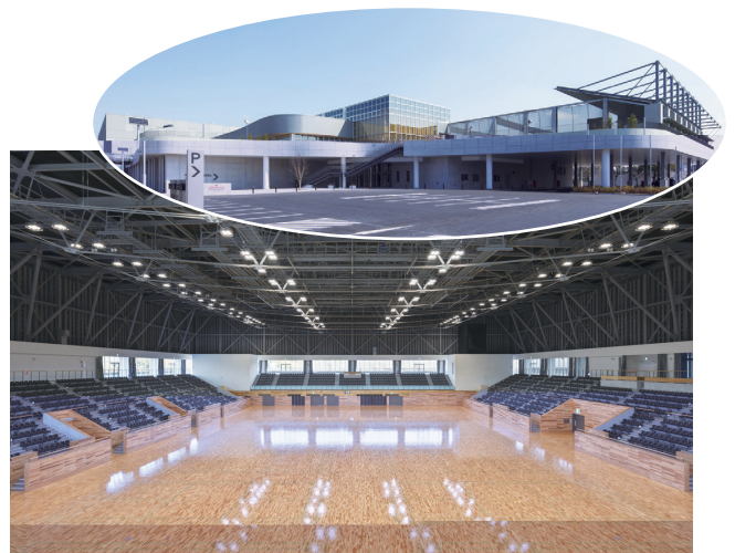
スポーツ施設の整備(久留米アリーナ 工事費約86億円) バスケットボールコート3面分のメインアリーナ、武道場、弓道場等を備える複合体育施設 (平成30年6月開館)
