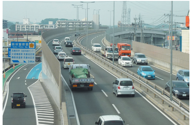
橋や道路の整備 飯塚市片島の立体交差道路 工事費約86億円) 平成22年8月に開通した一般国道200号の片島高架橋
