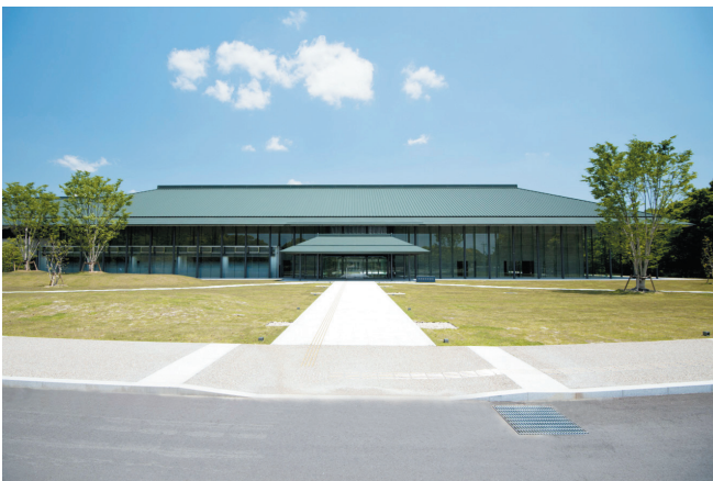
文化施設の整備(九州歴史資料館 工事費約36億円) 九州の歴史を明らかにするため、遺跡の発掘調査や各種文化財の調査・研究を行う歴史博物館施設 (平成22年11月小郡市に移転開館)
