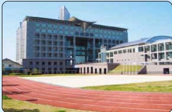
クローバープラザ（春日市） 工事費約159億円
