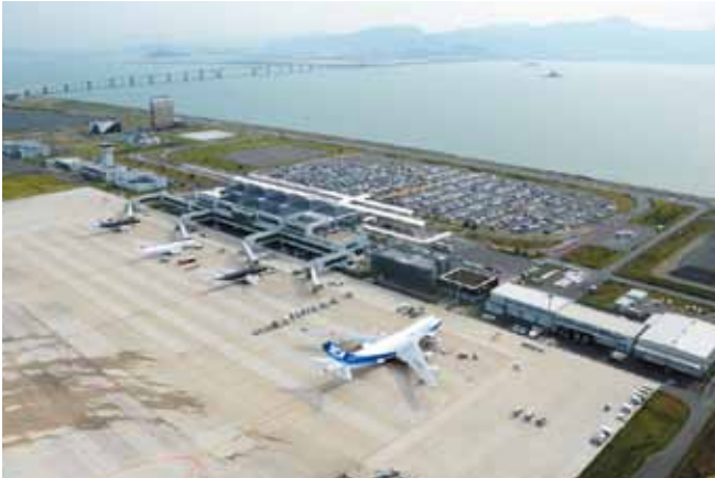
空港の整備(北九州空港 工事費約1,024億円) 平成18年3月に開港した周防灘 すおうなだ の3km沖合に位置する海上空港
