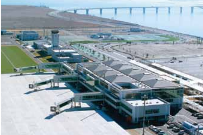
空港の整備(北九州空港 工事費約1,024億円) 平成18年3月に開港した周防灘 すおうなだ の3km沖合に位置する海上空港
