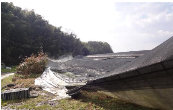
写真 倒壊した花き鉢物栽培ハウス
