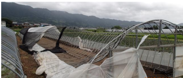
写真3 倒壊した軟弱野菜ハウス
